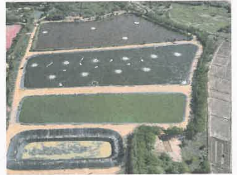
งานปรับปรุงระบบบำบัดน้ำเสีย ติดตั้งเครื่องเติมอากาศ และปูแผ่น HDPE ป้องกันการปนเปื้อนสู่สิ่งแวดล้อม
